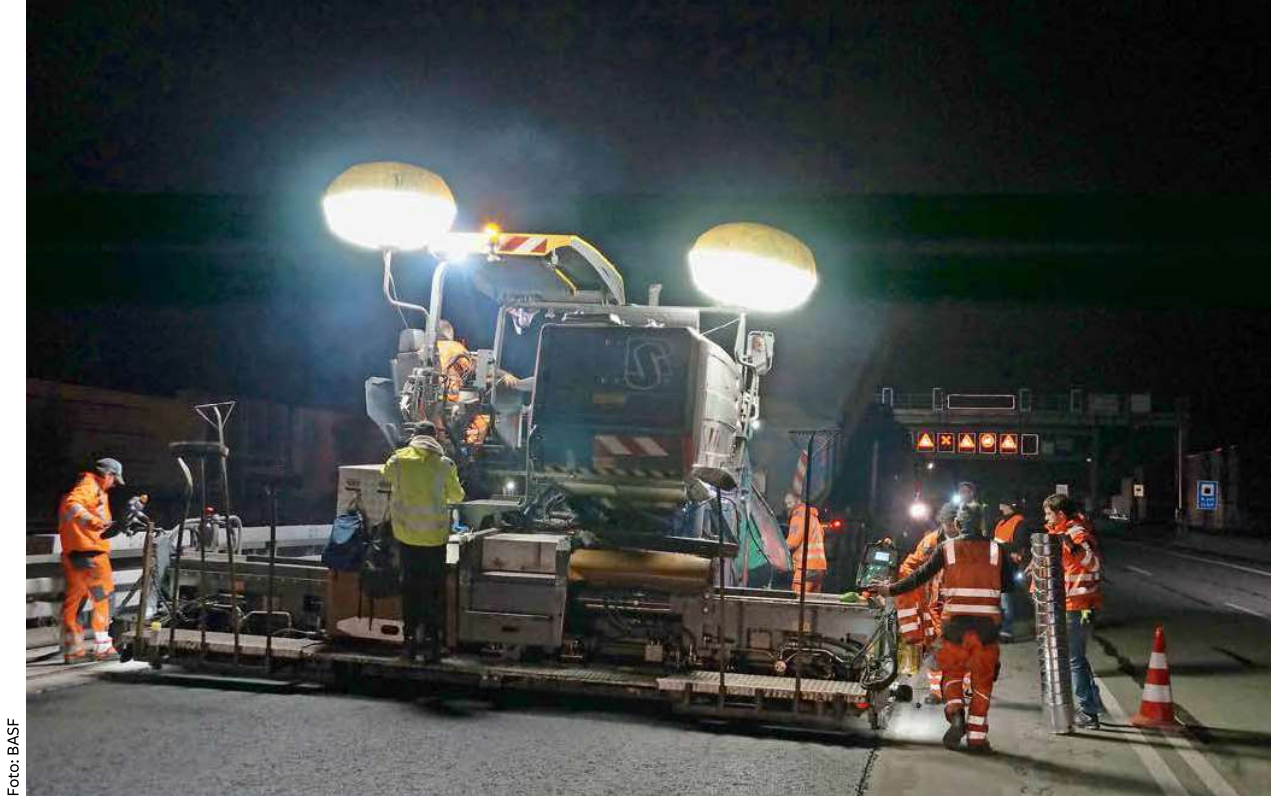
Einbau einer Asphaltbinderschicht mit einem modifizierten Warmasphalt auf der A 99
